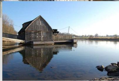
Allein die Wasserkraft der Weser treibt die 5m breiten Schaufeln des Wasserrades an und setzt so die hölzernen Kamm- und Korbräder und
